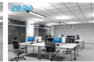
Chaque système d'éclairage est surdimensionné, au minimum de 20%. A la fin de la durée de vie, il réalise encore l'intensité d'éclairage requis. En utilisant le détecteur d'éclairage constant, nous pouvons réaliser des économies d'énergie de 20% au cours des premières années de la durée de vie.
