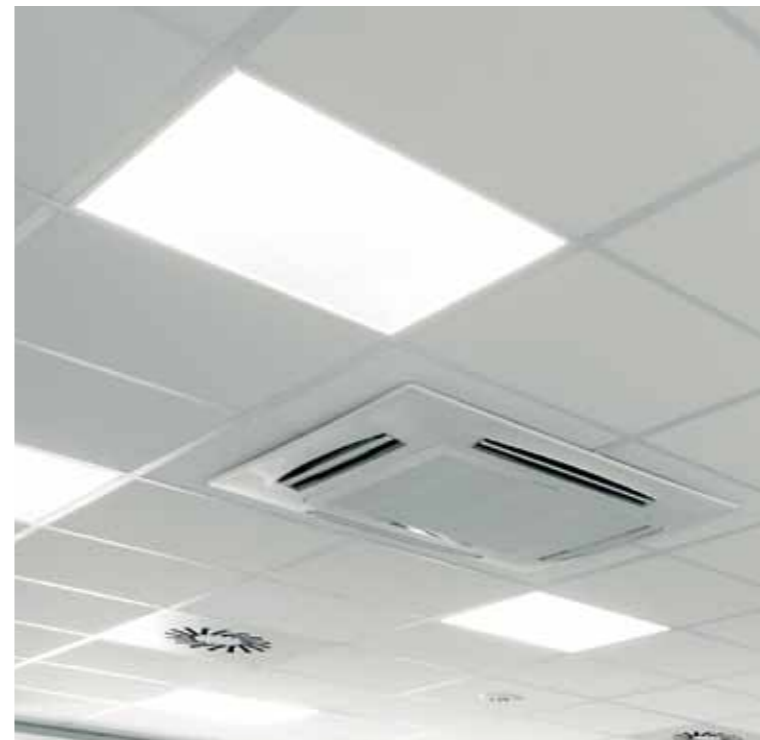
Il est valable que pour 2,5 W de la puissance du luminaire, 1 W de l'énergie de l'air conditionné est utilisé, c'est à dire si la consommation d'énergie du système d'éclairage augmente, la consommation d'énergie pour l'air conditionné augmente aussi en proportion directe.
