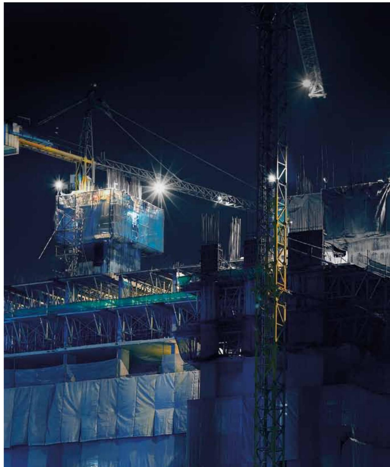
При размещении светильников необходимо учитывать расположение кабины крана, чтобы они не давали бликов при работе крановщика.
