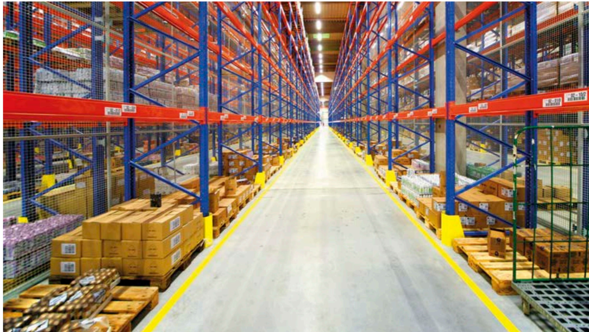
Der Präsenzmelder schaltet die Leuchten in ausgewählten Räumen dann ein, wenn sich jemand in ihnen befindet und folglich eine Beleuchtung tatsächlich notwendig ist.
