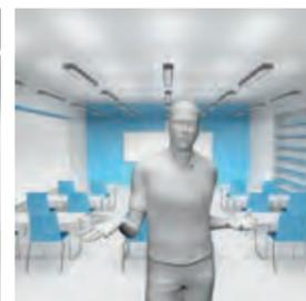
Pour la modélisation correcte des visages, il est important d'assurer aux salles de classe un éclairage cylindrique suffisant allant à 150 lux. Les luminaires suspendus avec une distribution directe et indirecte du flux lumineux, qui éliminent la formation d'ombres indésirables et en même temps qui ne provoquent pas d'éblouissement, sont la solution optimale.
