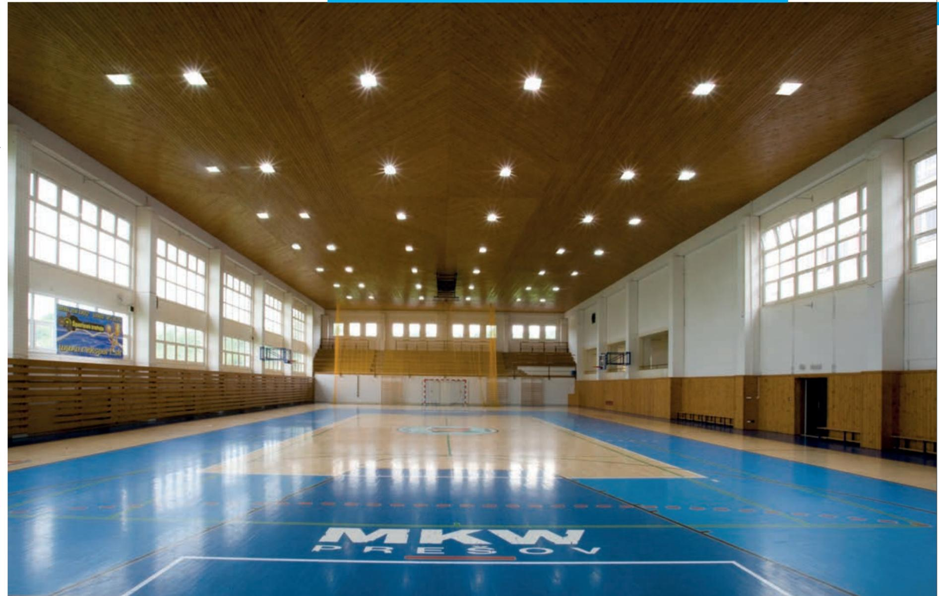
système de gestion intelligente dans la solution d'éclairage, qui permet par exemple d'atténuer différents groupes de luminaires ou d'utiliser les scènes d'éclairage. Dans les gymnases où la lumière du jour est disponible, il est recommandé d'utiliser le capteur de lumière du jour pour des économies. Puisqu'il s'agit d'un espace sans présence permanente de personnes, nous
