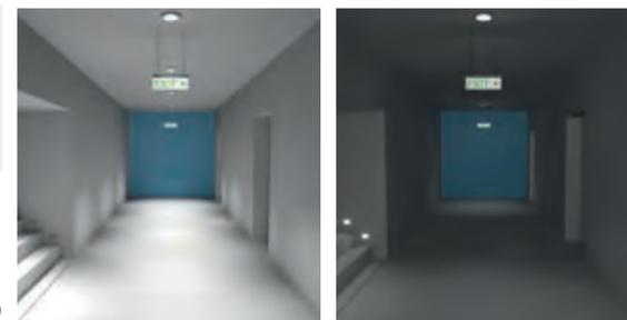
Pendant le fonctionnement normal, le niveau d'éclairement des zones de communication atteint les niveaux prescrits. Lors d'une panne de courant ou en cas d'incendie, l'éclairage de secours assure une visibilité et une orientation aux élèves lorsqu'ils quittent le lieu ou facilite leur accès aux extincteurs.
