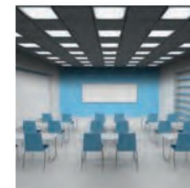
Les luminaires encastrés à grille, avec la caractéristique directe de la distribution du flux lumineux, ne sont pas adaptés pour les salles de classe. Nous n'atteindrons pas l'éclairage suffisant du plafond.
