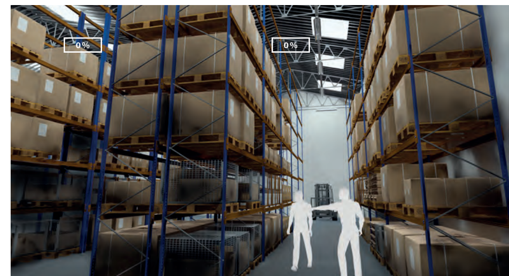
Pokiaľ je v regálových uličkách detekovaný pohyb a cez svetlíky preniká dostatočný podiel slnečného žiarenia, svietidlá sa kvôli šetreniu energie nerozsvietia a zostávajú zhasnuté.
