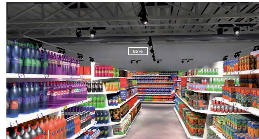
Všetky svietidlá svietia s rovnakým výstupným svetelným tokom ako jedna skupina na zvolenú svetelnú úroveň.
