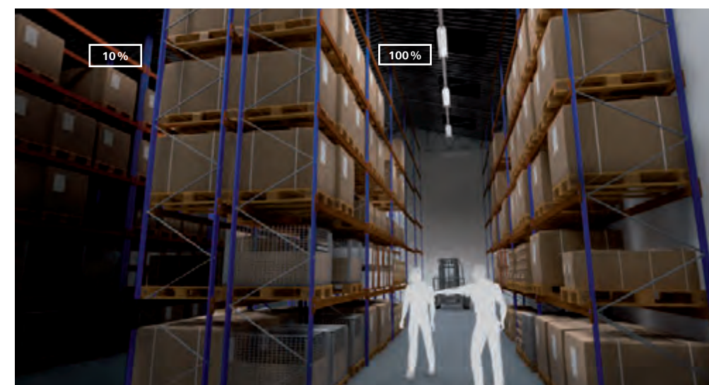
Ak je nedostatočný podiel osvetlenia z vonkajšieho prostredia a senzory v príslušnej časti skladu detekujú pohyb, svietidlá svietia na maximálny (prednastavený) svetelný tok len v danom priestore (danej regálovej uličke). Zostatok skladu svietia na bezpečnostnú úroveň, napríklad 10 %.
