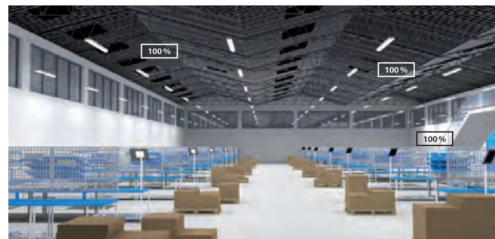
Ak z vonkajšieho prostredia nie je príspevok slnečného žiarenia, svetidlá svietia na plný výkon svetelného toku.
