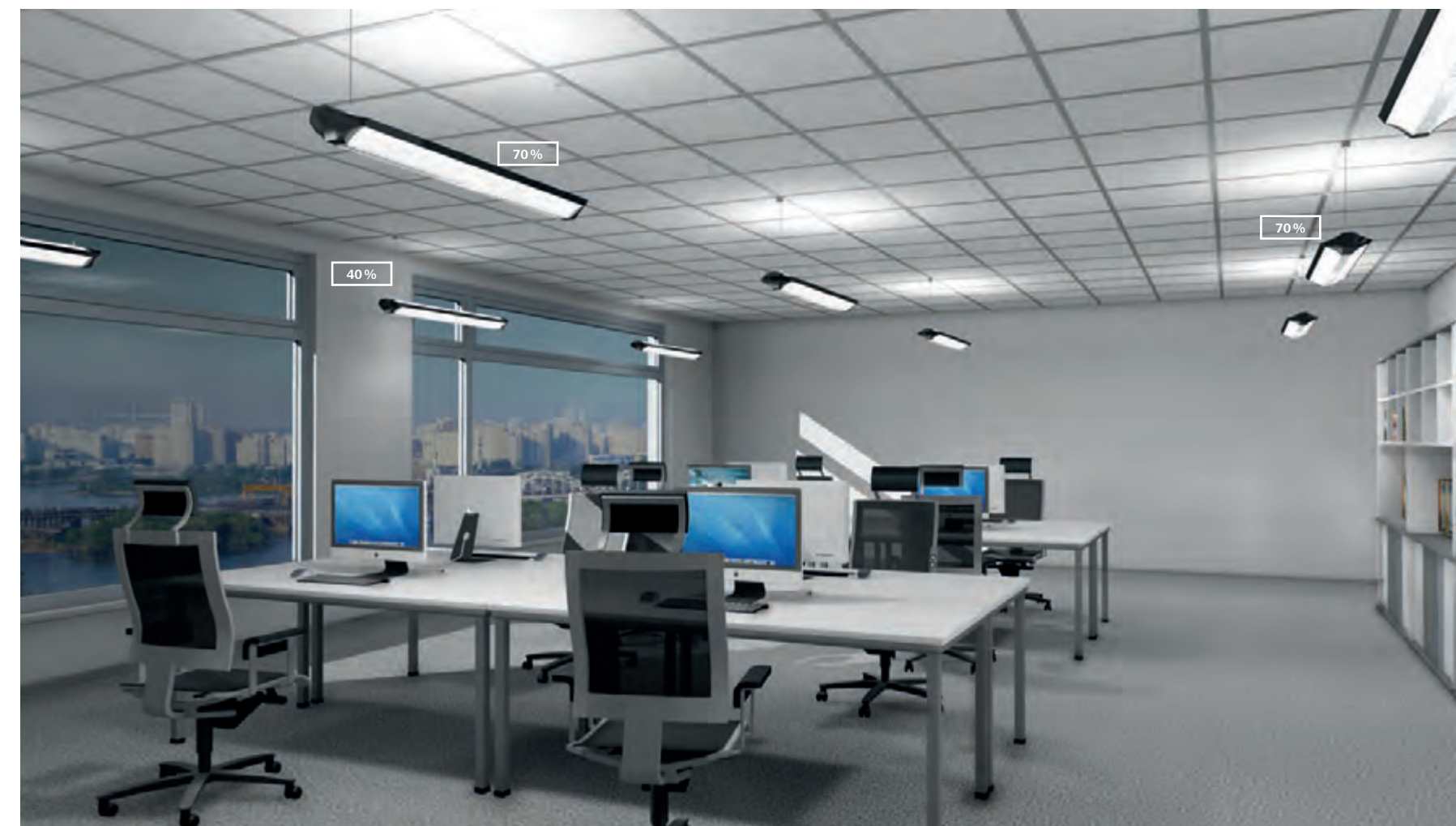
Využívanie dennej zložky svetla s využitím offset funkcie
