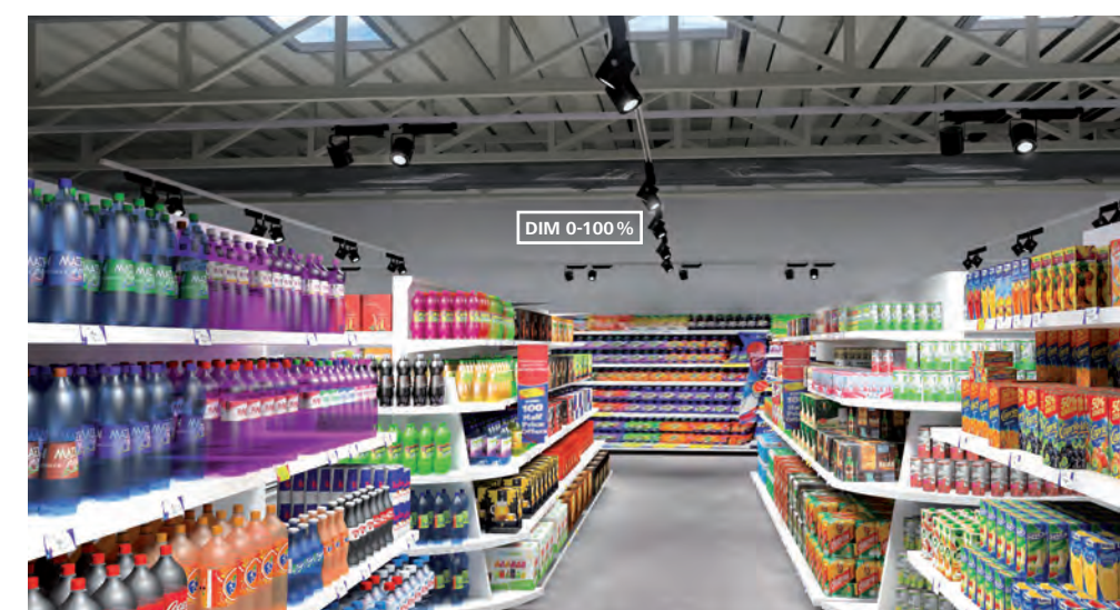
Možnosť pripojenia senzoru intenzity umožňuje centrálnemu napájacímu zdroju využívať prvky autonómnosti, ktorá sa prejaví plynulým automatickým stmievaním a rozsvetovaním podľa príspevku denného svetla cez svetlíky.
