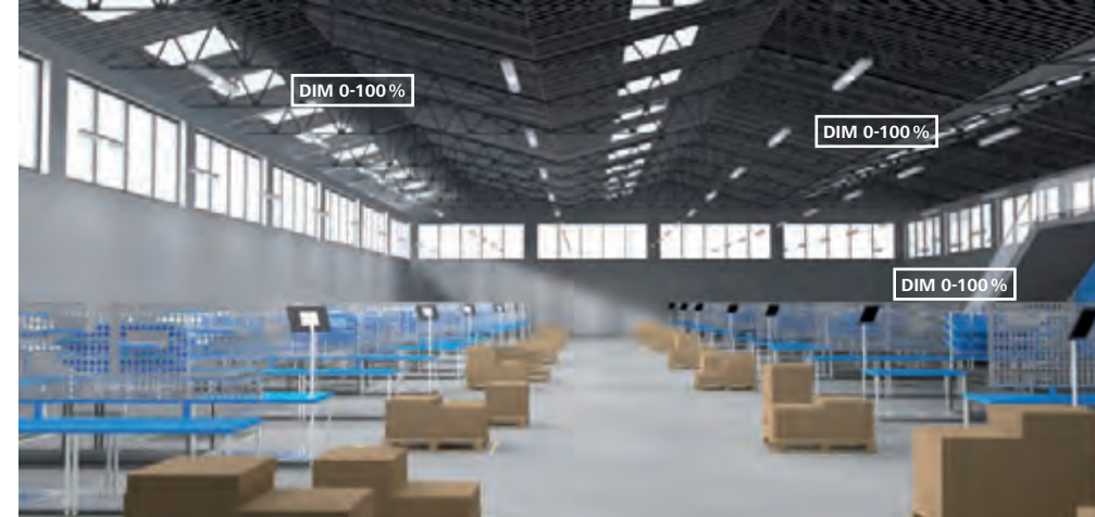
Riadenie na základe centrálného snímania intenzity. Jednotlivé skupiny svetiel je možné samostatne uviesť do automatického stavu (regulácia na základe intenzity) alebo pevne prednastavenej svetelnej scény.
