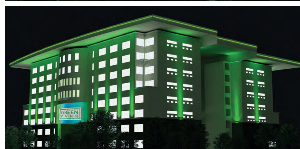
Pre zvýšenie iluminácie budovy je fasáda na priečelí doplnená o LED panely. Zobrazované videá sú do systému nahrávané cez video konverter.
