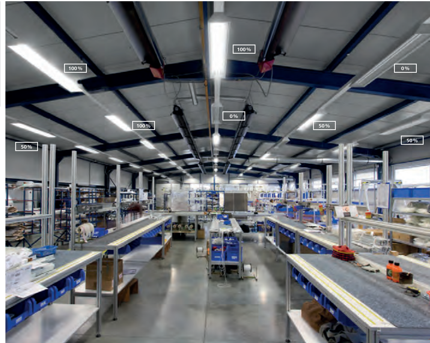
Svetelná scéna vyvolaná scénickým riadením. Pre každé pracovisko je zvolená svetelná úroveň, ktorá je potrebná pre aktuálne vykonávanú činnosť.
